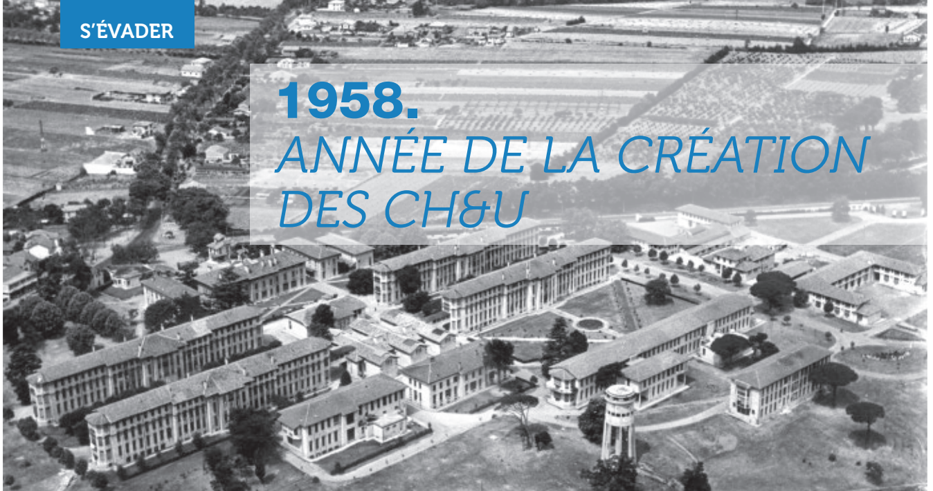
■ Vue aérienne du CH&U
