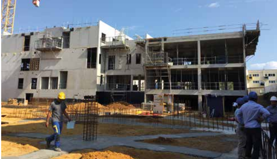
■ La construction de la nouvelle maternité de Saint-Gaudens
