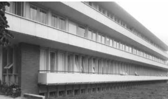
■ Façade ouest du nouveau bâtiment de pédiatrie.
