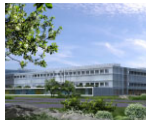
Janvier 2010 Les premiers bétons de la CUC sont coulés
