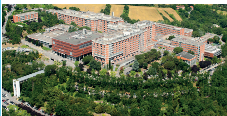
Site RANGUEIL Plateau technique automatisé (en miroir avec Purpan)
