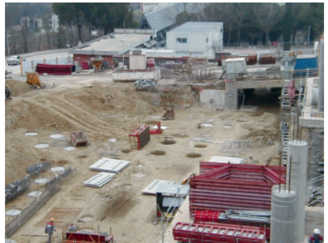
Le début du chantier en février 2008.
