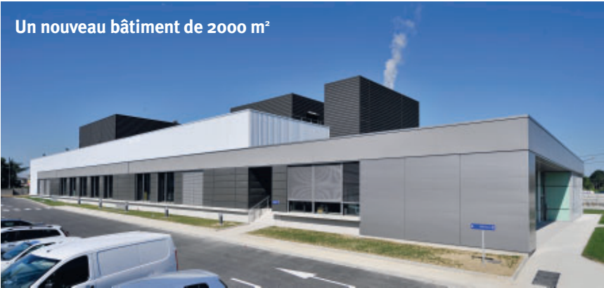
Edifié sur le site du Chapitre près de la blanchisserie et de la cuisine centrale, le bâtiment de l'Unité centrale de stérilisation a une surface utile de 2000 m 2 . 1400 m 2 sont affectés au process.
