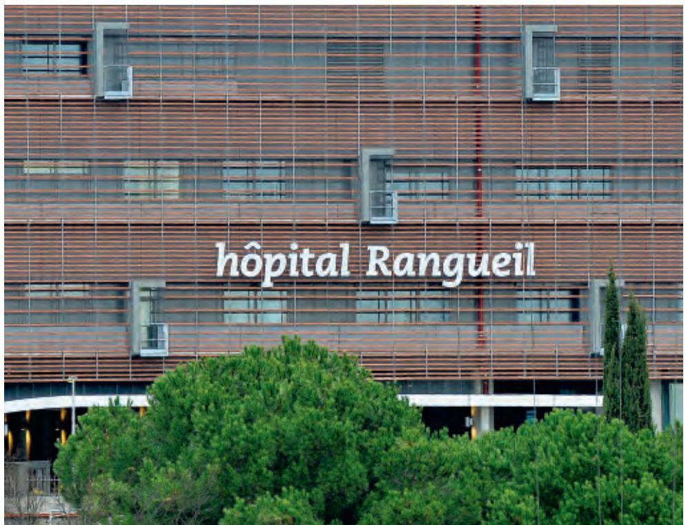
Le nouvel accès à l'hôpital Rangueil, ouvert le 5 janvier 2011, permet un accueil facilité et convivial des usagers.
