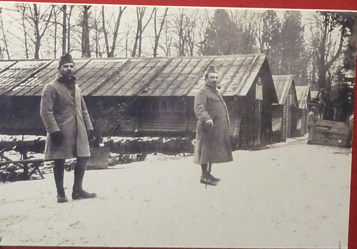
« ... Sommes-Suippes « Baraques Adrian et rez-de-chaussée d'un ancien orphelinat. La baraque n°1 servira à deshabillage, réchauffement, radioscopie et opérations » (du 27/10/1917 au 9/03/1918)... » (À droite, Prosper Viguière)
