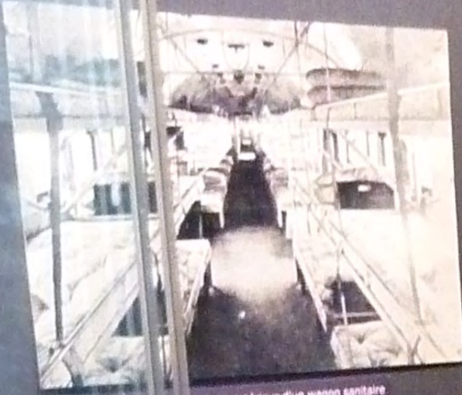
6 - Aménagement intérieur d'un wagon sanitaire
